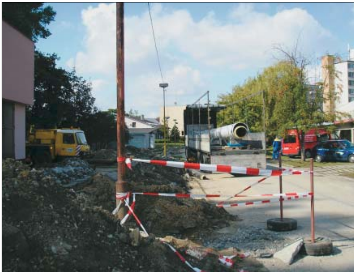
Příprava montáže podpěrného pilonu pro kofovody
