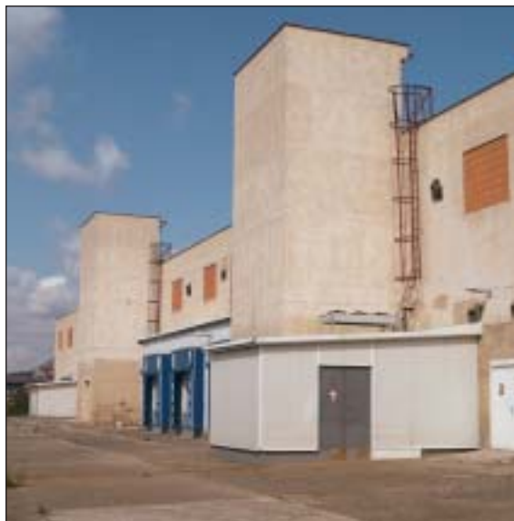
Výrobní objekt strojovny tepelných čerpadel
