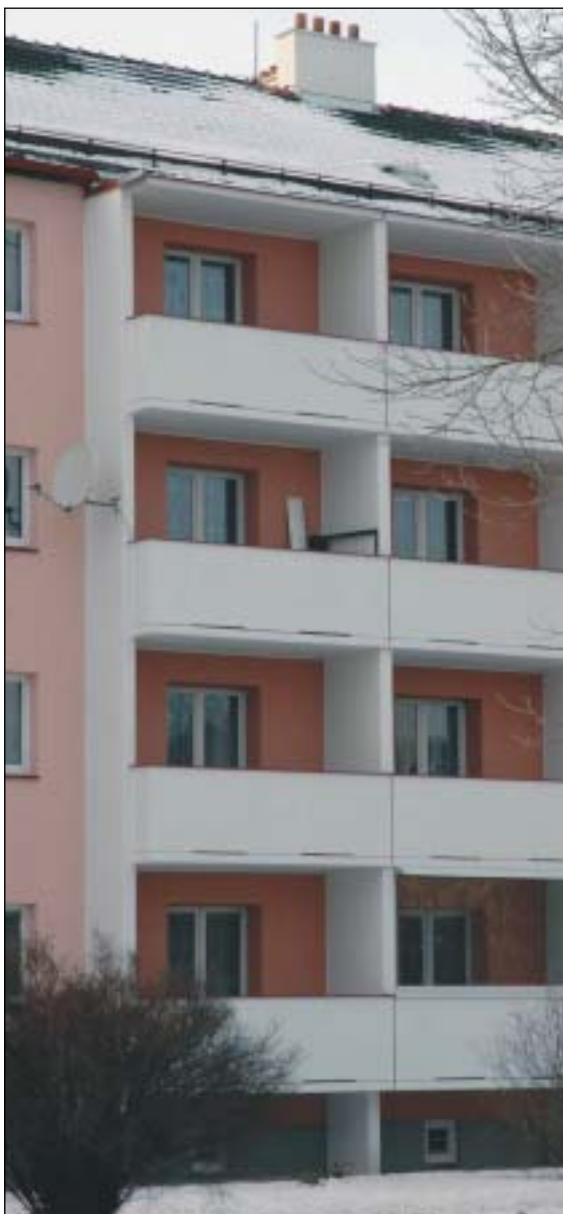
Detail objektu po přístavbě prefabrikovaných železobetonových lodžii
