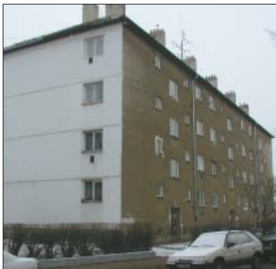
Skopalíkova 30-34 - původní stav objektu
