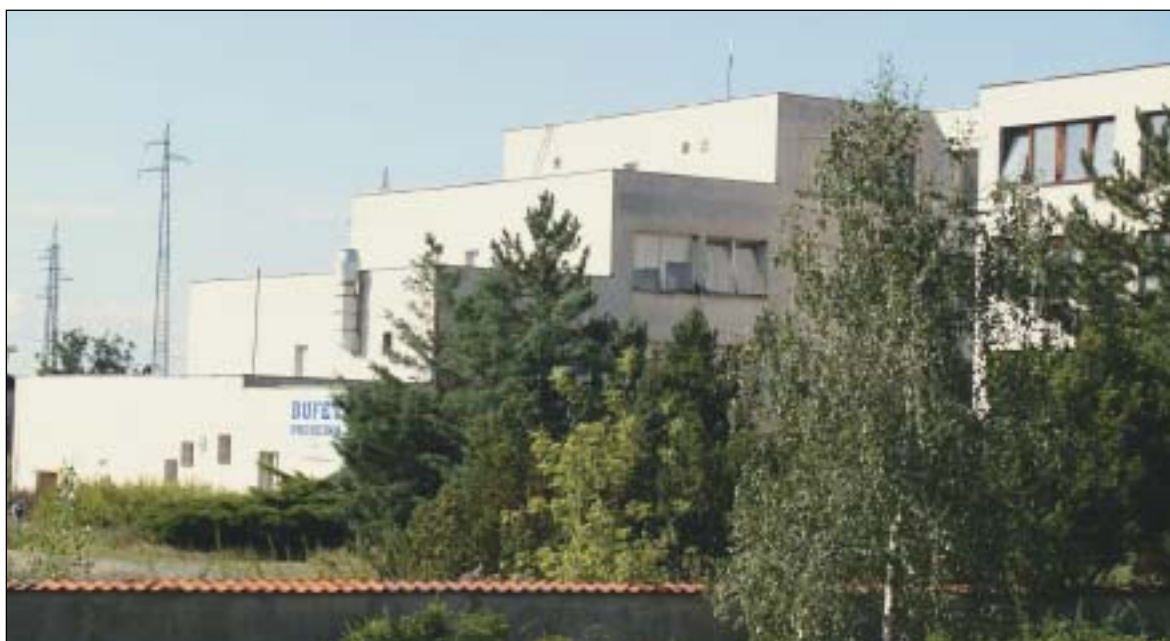
Ubytovna, administrativní budova - severovýchodní pohled
