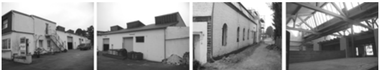
Abb. 1 Bestandsfotos: bestehende Kfz-Lackiererwerkstatt vor der Sanierungsmassnahme
