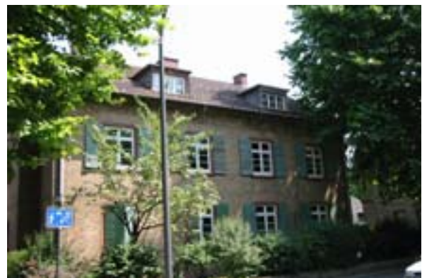
Abbildung 1: 'Meisterhaus', Bj. 1892. Ehemalige Werksiedlung der BASF in Ludwigshafen. Vormauerziegel 12 cm als sichtbare Außenschale, Hintermauerziegel 24 cm. Laibung Sturz und Fensterbank aus profiliertem, rot durchgefärbtem Beton.
