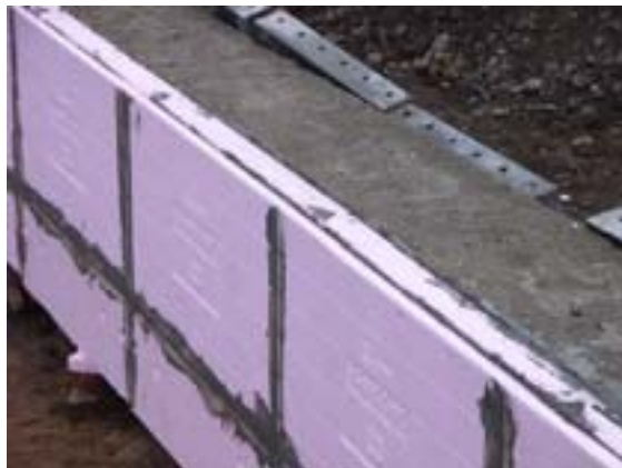
Obr.3 Zateplení základu
