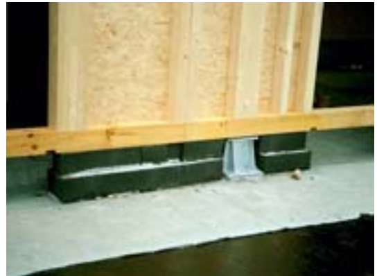
Holzbau auf Schaumglasschwelle
