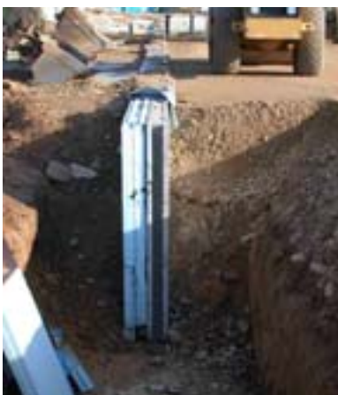
Aufbau der Frostschrze
