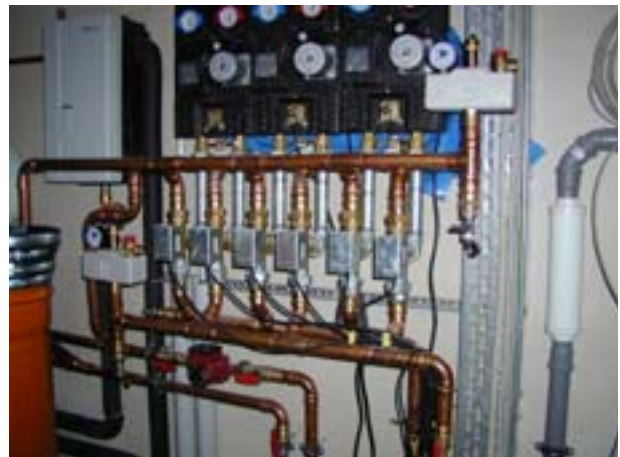
Pumpenbaugruppe für Geschossweises Heizen + Kühlen
