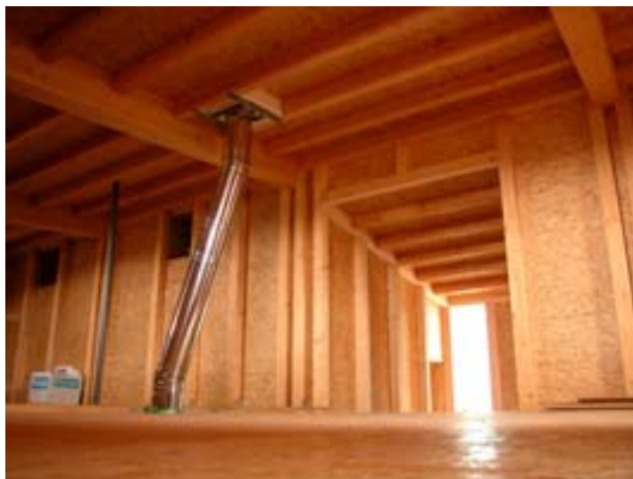
Hrubá stavba s viditelnými trámy z interieru před omítáním
