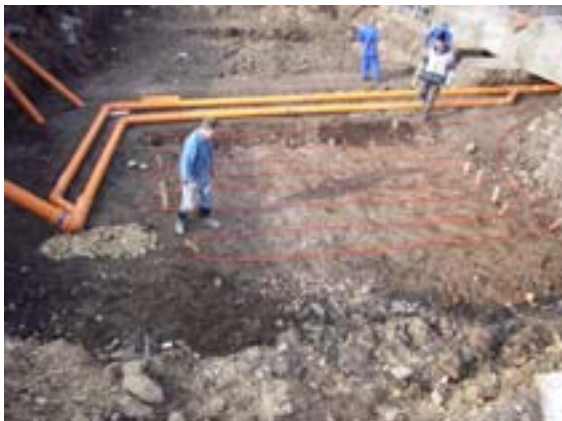
Obr.2 Pokládka zemního přehříváče
