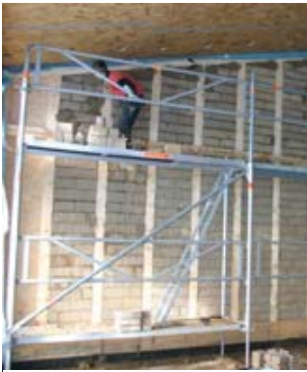
Lehmsteinausmauerung der Innenwände
