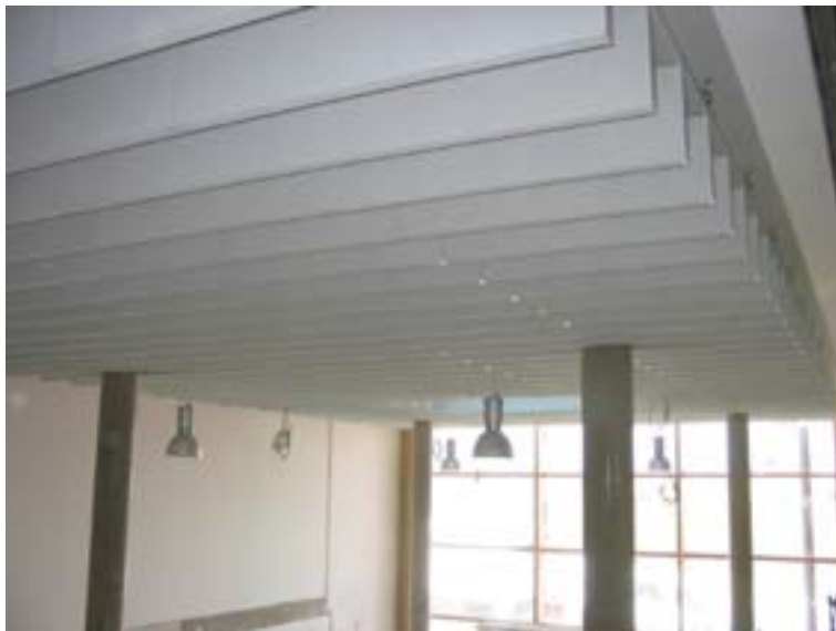
Abb. 5 Baffeldecke mit vertikal angeordneten Schallabsorbern – Ausführung im Foyer
