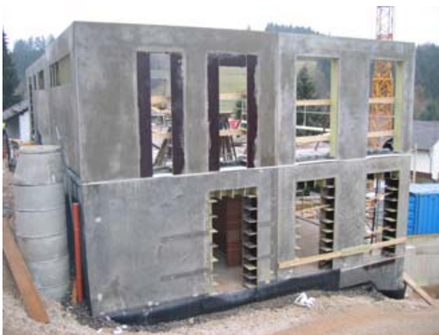
Wandmontage Typ 270 auf Typ 330 im linken Bildrand sichtbar der Drainagekontrollschacht für die übereinander liegende Drainage
