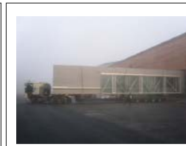
Abb 15-17: Produktion und Transport der vorgefertigten Fassadenelemente (Juli 2006)
