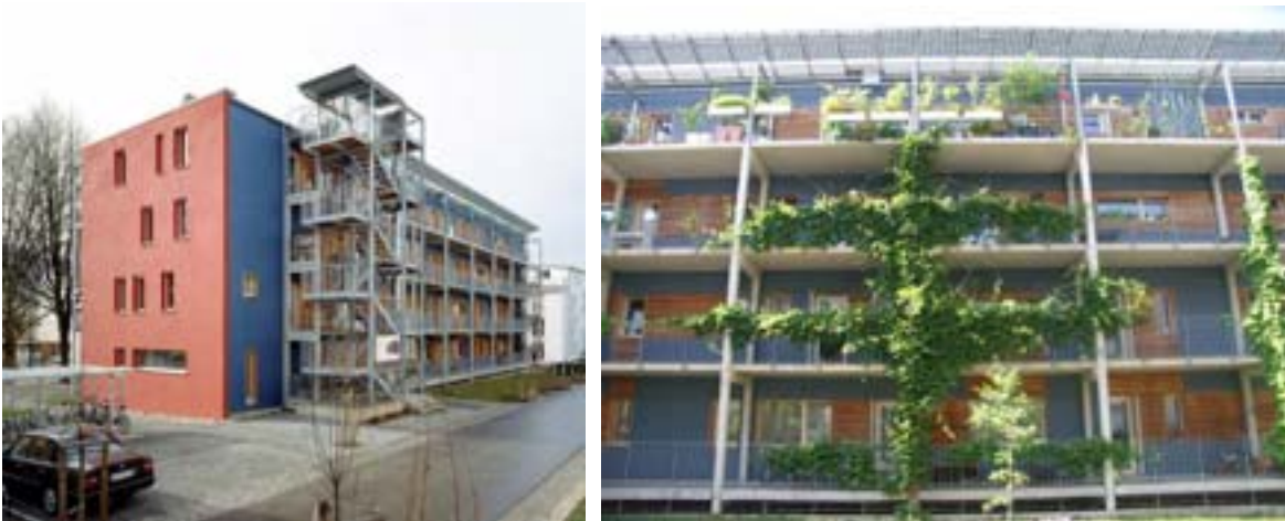
Abb. 6 und 7 Ansichten von Nordosten und Norden 20% Fensteranteil, Treppe und Gänge außerhalb der thermischen Hülle
