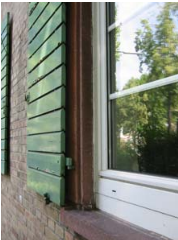
Abbildung 1: 'Meisterhaus', Bj. 1892. Ehemalige Werksiedlung der BASF in Ludwigshafen. Vormauerziegel 12 cm als sichtbare Außenschale, Hintermauerziegel 24 cm. Laibung Sturz und Fensterbank aus profiliertem, rot durchgefärbtem Beton.
