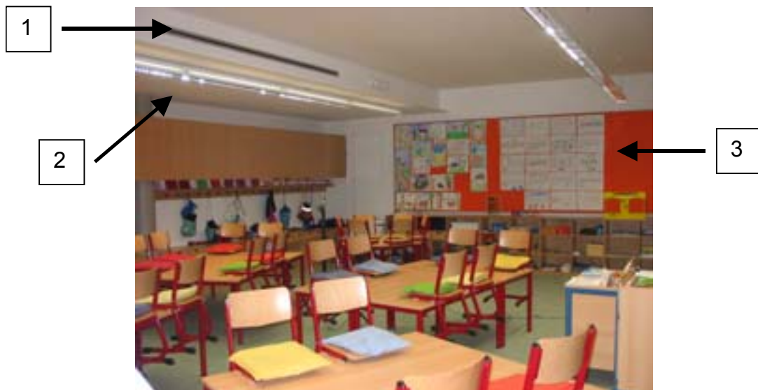
Abb. 4 Unterrichtsraum der Grundschule (1) Deckenkoffer für Lüftungsleitungen mit Schlitzauslässen (2) raumakustische Maßnahmen an Deckenkoffer Gipskartonlochplatten (3) raumakustische Maßnahmen an Rückwand Absorberelement als Pinnwand
