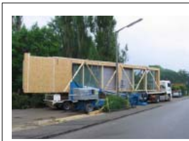
Abb 15-17: Produktion und Transport der vorgefertigten Fassadenelemente (Juli 2006)
