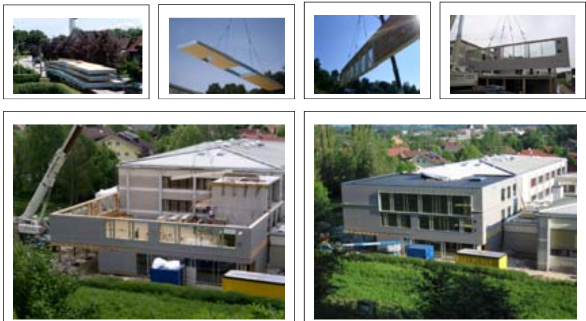
Abb 18-23: Transport und Montage der vorgefertigten Fassaden- und Dachelemente (Juli 2006)
