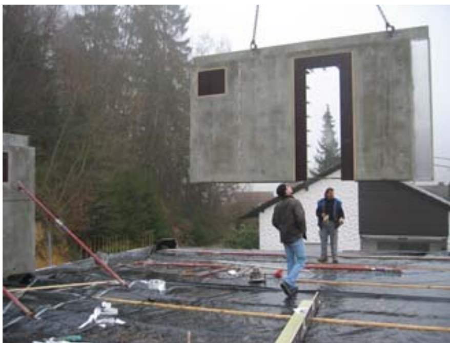
Wanmontage TYP 270 mit Transportanker
