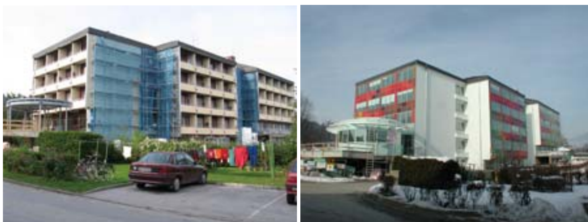
Obr. 1 Domov dôchodcov vo Weizi pred (vľavo) a po energetickej sanácii (vpravo)
