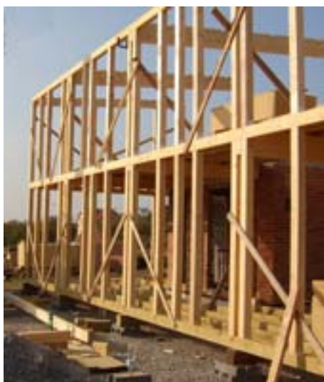
Nosná viditelná trámová konstrukce
