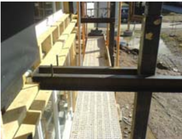
Abb. 13 und 14 Zur Vermeidung von Kältebrücken wurden die Anschlüsse der Balkonkonstruktionen optimiert.
