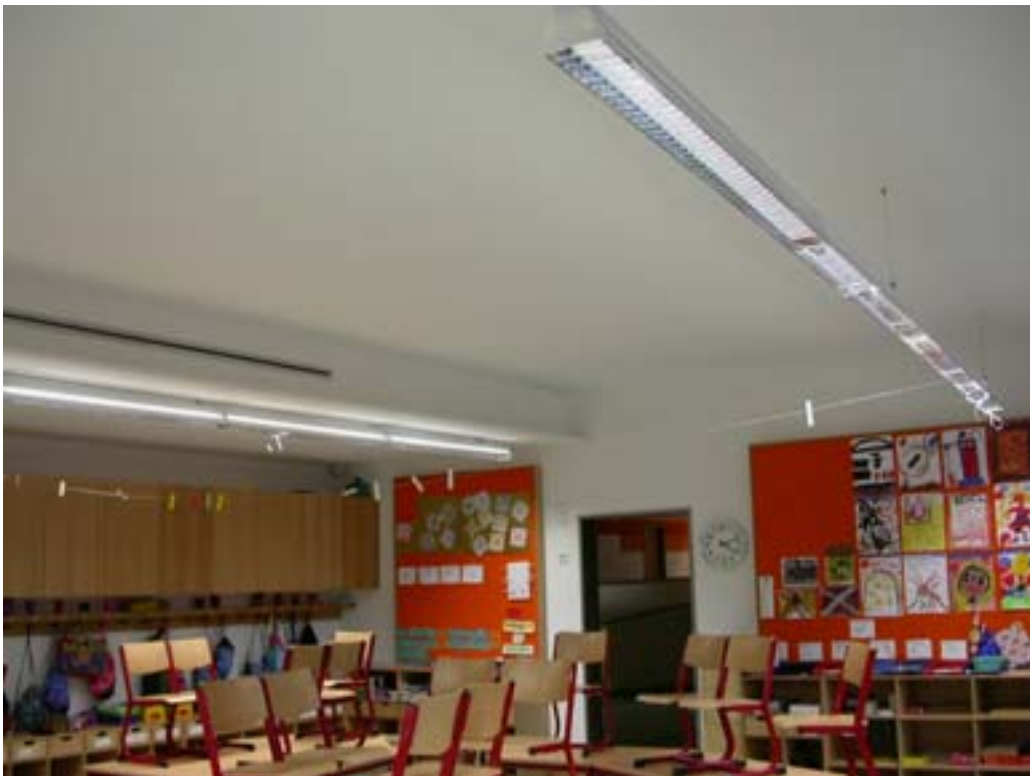
Klassenraum mit abgehängter Decke, Akustik-Pinnwand, Weitwurfschlitz (Zuluft)
