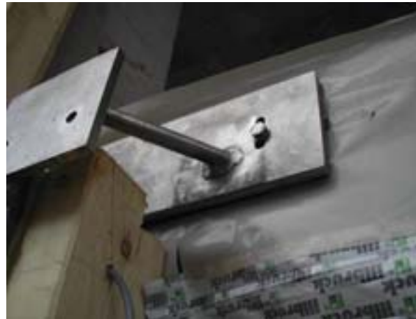
Abb. 13 und 14 Zur Vermeidung von Kältebrücken wurden die Anschlüsse der Balkonkonstruktionen optimiert.
