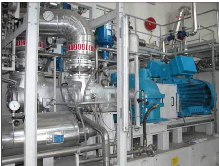
Obrázek 15: Parní stroj se šroubovým rotorem v biomasové teplárně Hartberg (el. výkon 710 kWe)
