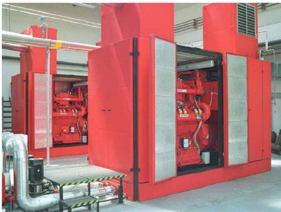
Obrázek 16: Kogenerační jednotka na bioplyn TBG 520 firmy Motorgas (520 kWe, 725 kWt)
