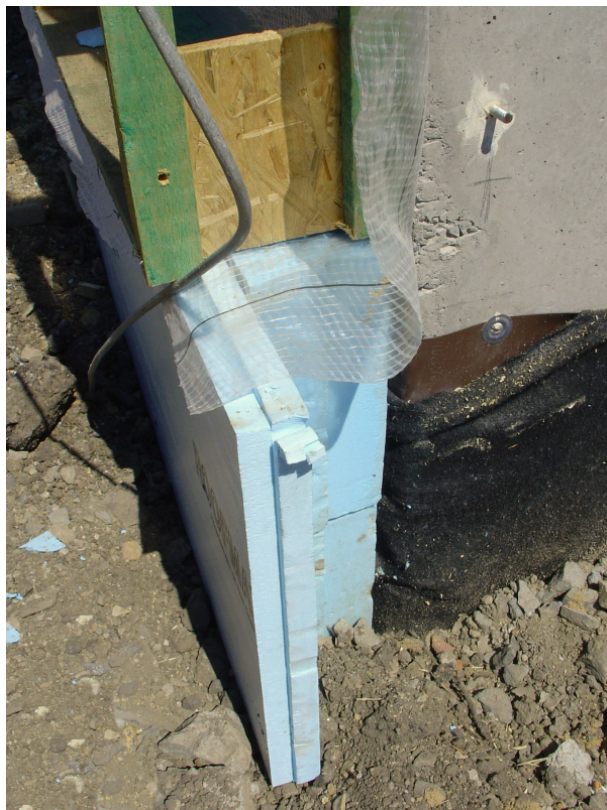
Obr. 4 Extrudovaný polystyren se používá především tam, kde dochází ke kontaktu tepelné izolace se zemí. Na obrázku je použití při izolaci soklu seminárního centra v Hostětíně. Pro izolaci vrchní betonové stěny byla použita minerální vlna vkládaná mezi lepené I-profilů.
