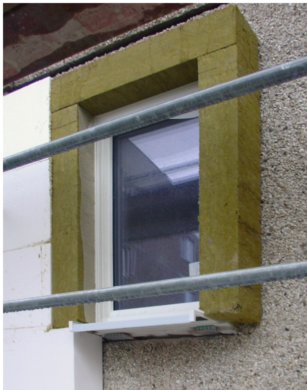
Obr. 5 Výhodou izolace z minerálních vláken je její nehořlavost. Zde při sanaci mateřské školy v Drážďanech na úrovni pasivního standardu bylo vytvořeno nehořlavé ostění okna. Minerální vlna se často používá v kombinaci s polystyrenem.
